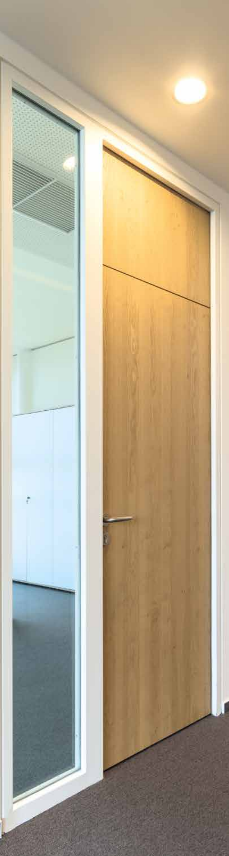
Bürogebäude DEK, Hamburg hochwertiges Schallschutztürelement mit Oberblende high-quality sound insulation door element with top panel
