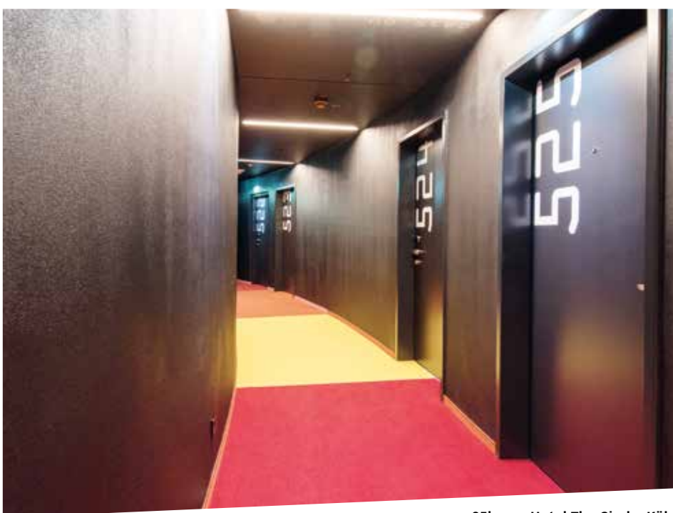
25hours Hotel The Circle, Köln Blick in den Hotelflur, Hotelzimmertüren mit Rauch- und Schallschutz SSK 3, RWP = 42 dB View down the corridor, Hotel room doors with smoke- and sound protection SSK 3, RWP = 42 dB
