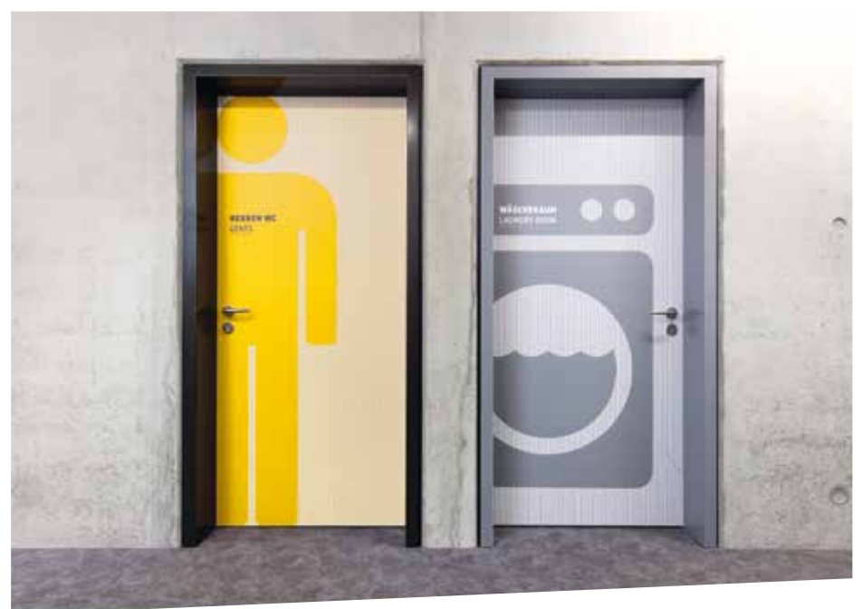
DJH Jugendherberge Bayreuth Oberflächen HPL Resopal mit Motiven Surface HPL Resopal with signs
