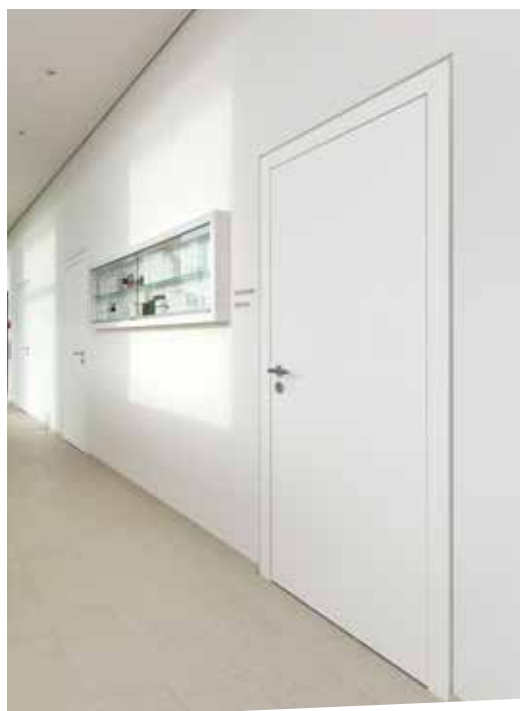
Elemento de insonorização / Soundproofing element Porta, caixilho e parede embutidos, ranhura de fixação circundante Flush door, frame and wall, shadow groove all around
