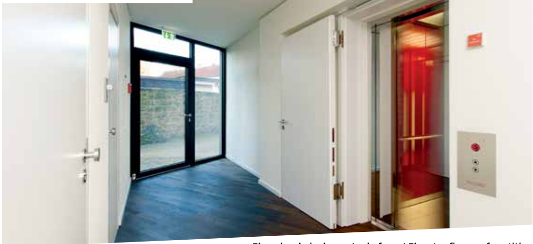
Elevador de isolamento de fogo / Elevator fireproof partition Elemento de proteção contra incêndios com fixação (magneto de fixação) Fire protection element with arrester (holding magnet)
